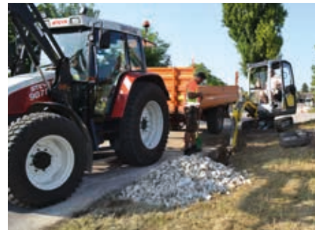
Oberflächenentwässerung am Graßnitzberg
