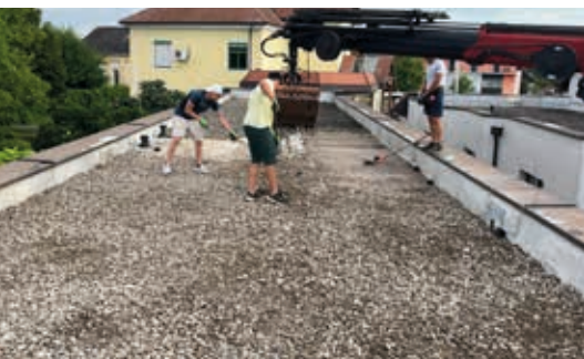
Dachsanierung in Lichendorf
