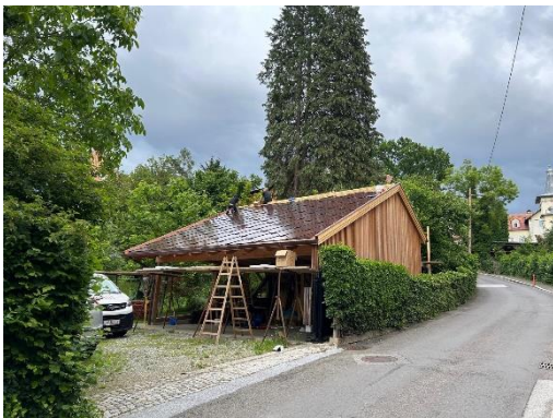
PV Module als kleinformatige Dachdeckung in rotbrauner Farbe
