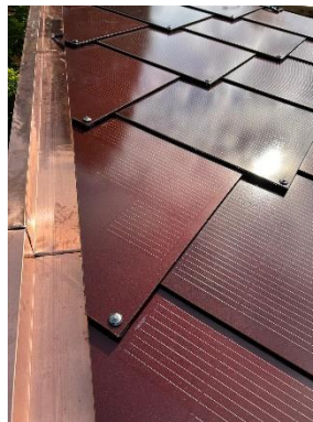
PV Module als kleinformatige Dachdeckung in rotbrauner Farbe
