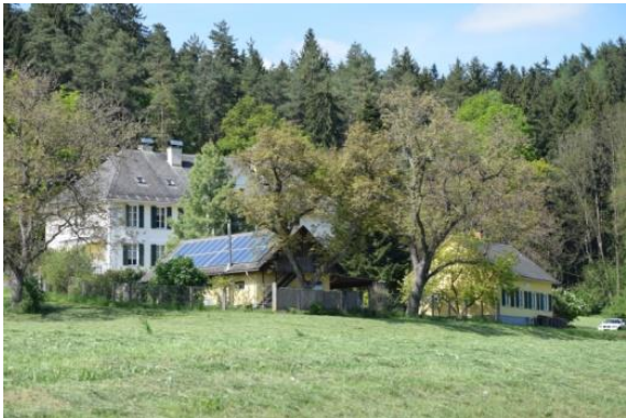
PV Module am Satteldach des Nebengebäudes
