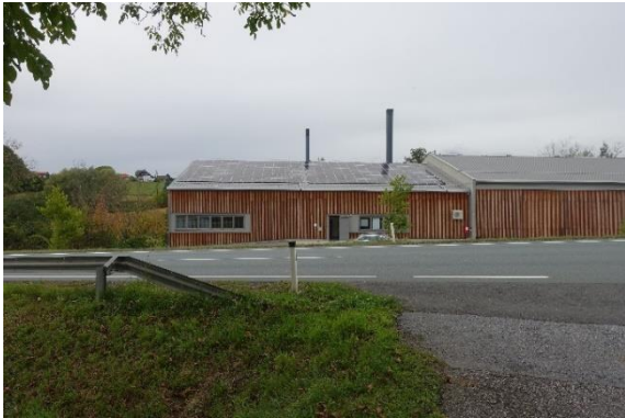
Integration von PV Modulen in die Dachfläche (graue Module, graues Dach) Nahwärme Pischelsdorf
