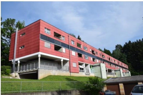
PV Module als Integration in das Fassadenkonzept
