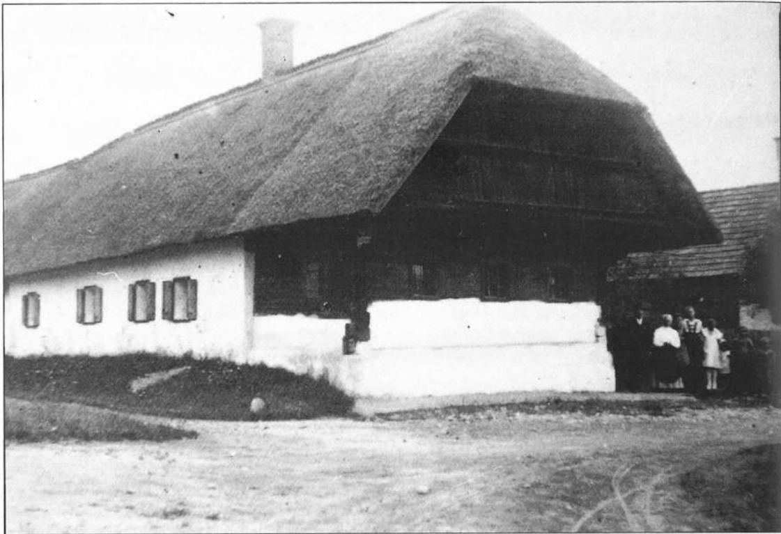
Altamtman-Haus zu Gersdorf. Zustand um 1924.
